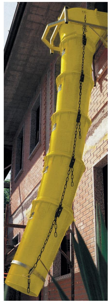
Propres et économiques, ces goulottes en polyéthylène haute densité (HDPE), résistent bien aux chocs, aux écarts de température et au vieillissement. Indispensables dans les chantiers de rénovation, elles permettent de réaliser à partir du cadre de départ réglable, de la goulotte de départ et des goulottes, des conduits d'évacuation pour les gravats, elles sont modulables et étanches. (10 m maximum sur un cadre de départ)
